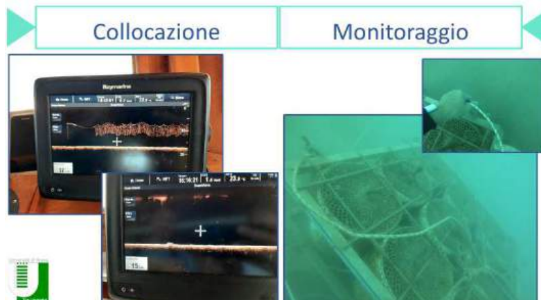
Figura 6 Sistemazione dei moduli per la cattura del sedimento su fondale
