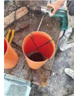
c) Inserimento del ferro per la tenuta del cls.
