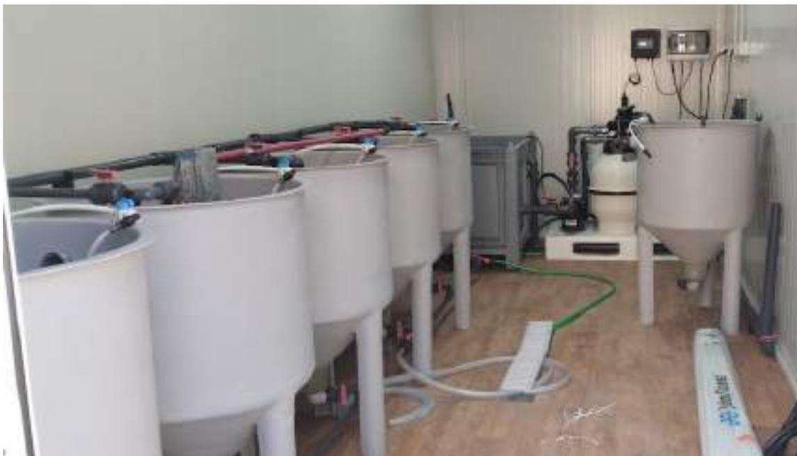
Box per i riproduttori e le larve di riccio di mare *Paracentrotus lividus* con vasche troncoconiche, sump, pompa e filtro meccanico, lampada UV e centraline di controllo in allestimento.
