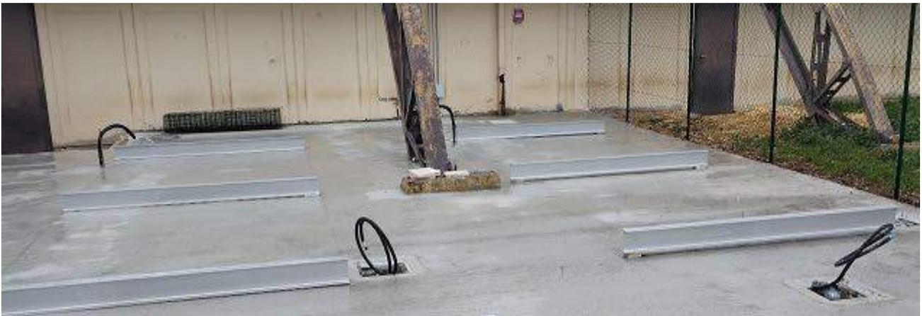
Massetto di cemento armato con putrelle per la posa dei box.
