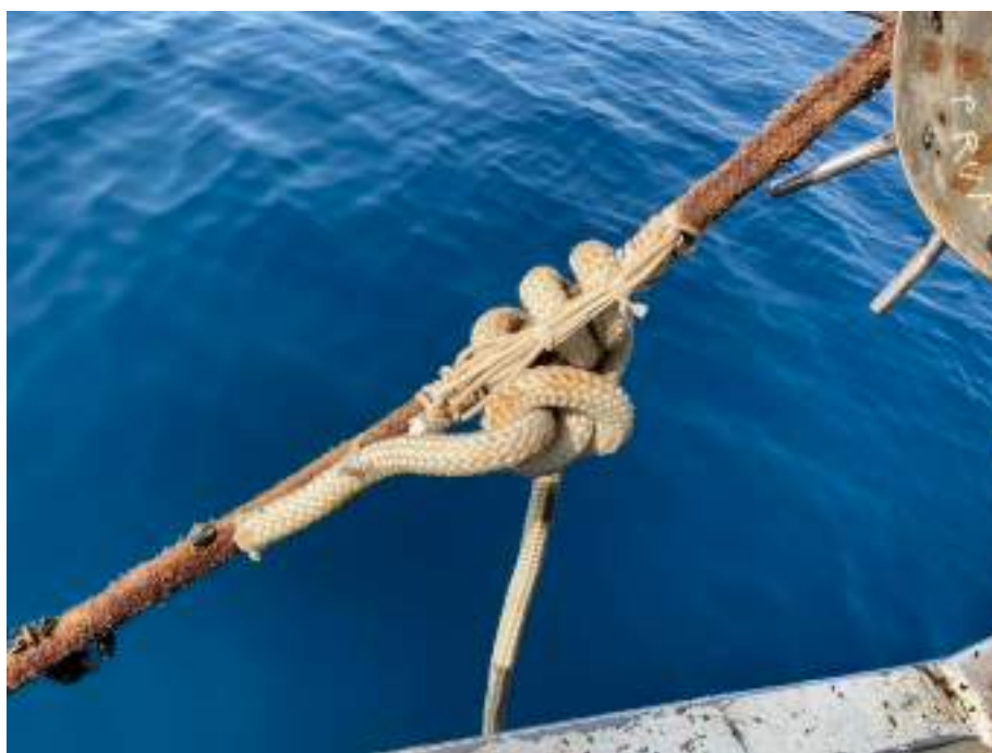
Figura 27- Particolare del sistema di fissaggio della boa alla campata dell'impianto di produzione
