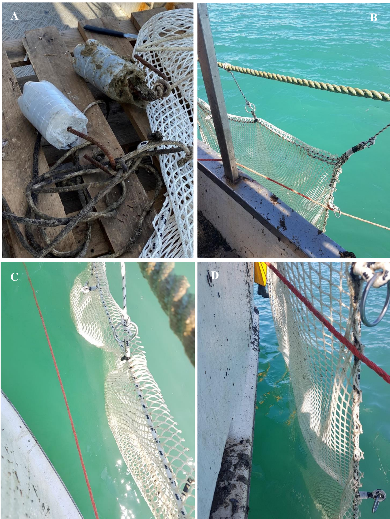
Figura 24- Dettagli del posizionamento delle vele sui long-line. A- Corpi morti di ancoraggio. B-C-D Inquadrature frontali e laterali delle vele durante la loro messa a dimora. Notare i dettagli delle maglie e gli anelli perimetrali.
