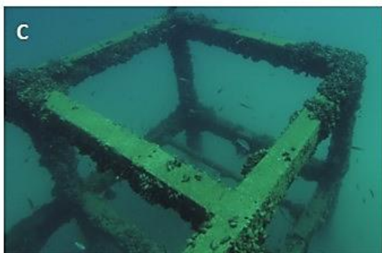
Figura 25- A-E. Rilievi fotografici in immersione su una delle strutture artificiali cave (gabbioni) in calcestruzzo posizionate nell'impianto di mitilicoltura Adriatica Off Shore s.r.l. Le foto mostrano la struttura da diverse angolazioni.
